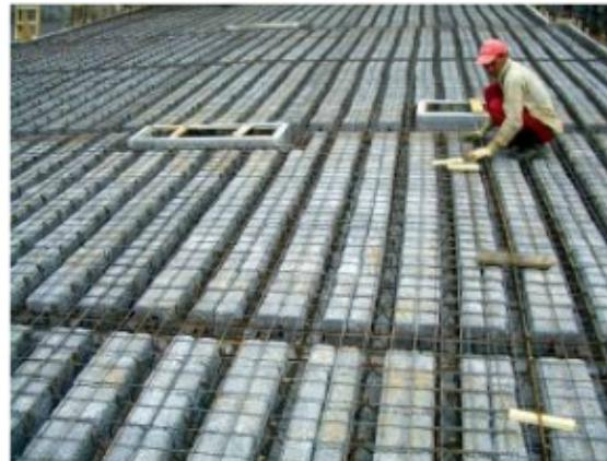
**SPP** Simprolit medjuspratna polumontažna tavanica sa montažnim blokovima
