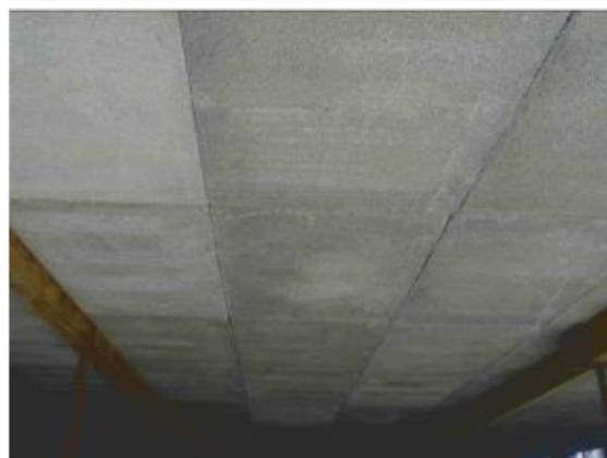
SMP Simprolit® medjuspratna ploča sastoji se od SOP ploča ispod i rebara izrezanih od SOP ploča, tačkasto fiksiranih za donje SOP ploče gradjevinskim lepkom, što sve daje trajno zarobljenu oplatu za sitnorebrastu tavanicu, koja se formira armliranjem i betoniranjem medjurazmaka Simprolit rebara. Zapreminska težina ploča i rebara je  $160,0 \text{ kg/m}^3$ .
