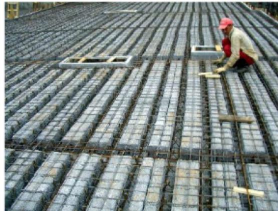
**SEPP** Simprolit medjuspratna polumontažna tavanica sa montažnim blokovima
