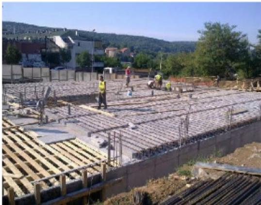
**SMP** Simprolit medjuspratna polumontažna tavanica sa montažnim rebrima
